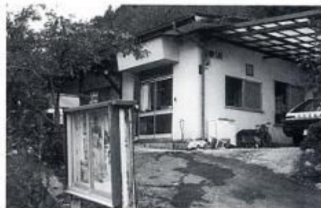
昭和46年新築の山清路駐在所
