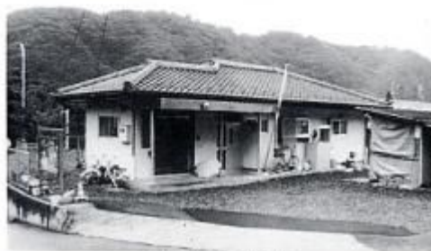
昭和56年新築の駐在所
