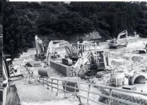
吉坂の災害復旧作業
