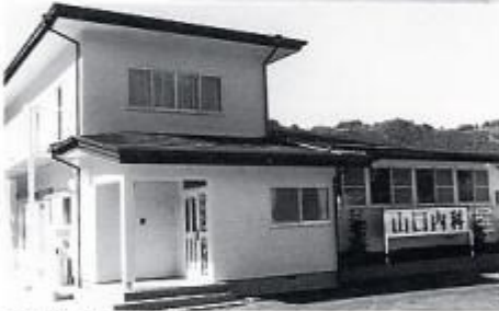
平成元年10月新築の山口医院
