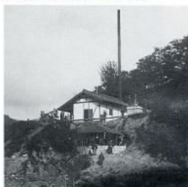
大正2年上生坂の蒸気機関揚水場（県内初）
