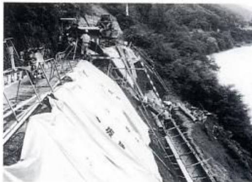
下生野積手の道路復旧工事（平成元年）
