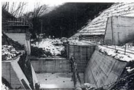
小立野入の堰堤工事（平成元年）
