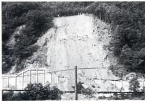
雲根国道上の地すべり 国道は交通止めとなる
