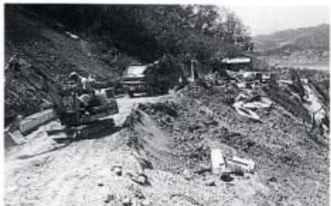
小立野の災害復旧工事
